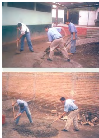
Trabajos de mejoras en Tegucigalpa
