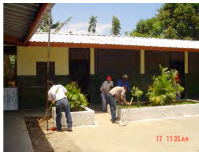
Trabajos de mejoras en La Ceiba.
